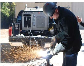
Corte manual en obra
