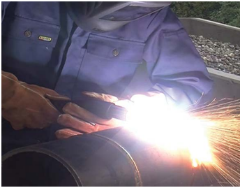
Remoción de soldadura
